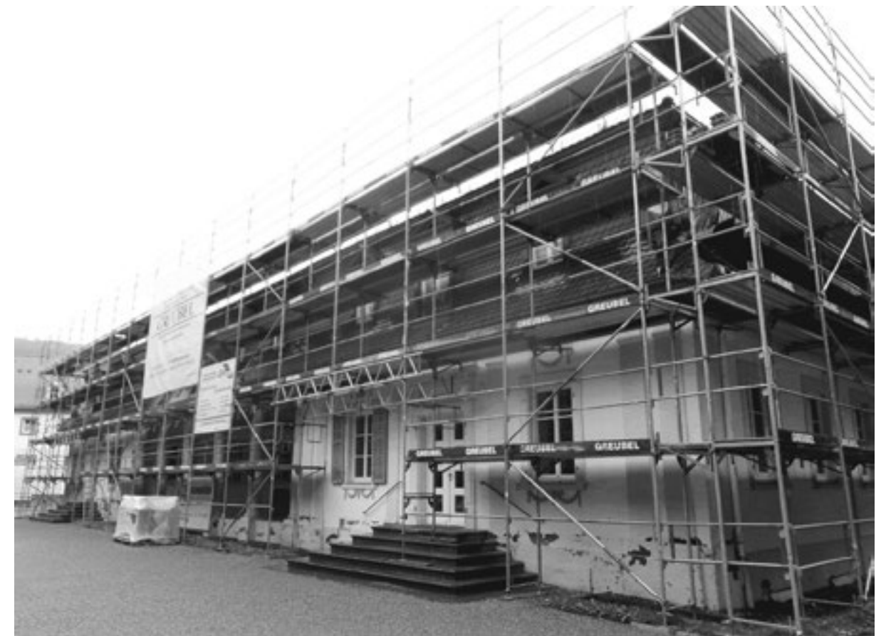
Noch bis in den Spätherbst laufen am Bad Bockleter Brunnenbau Sanierungsarbeiten.
